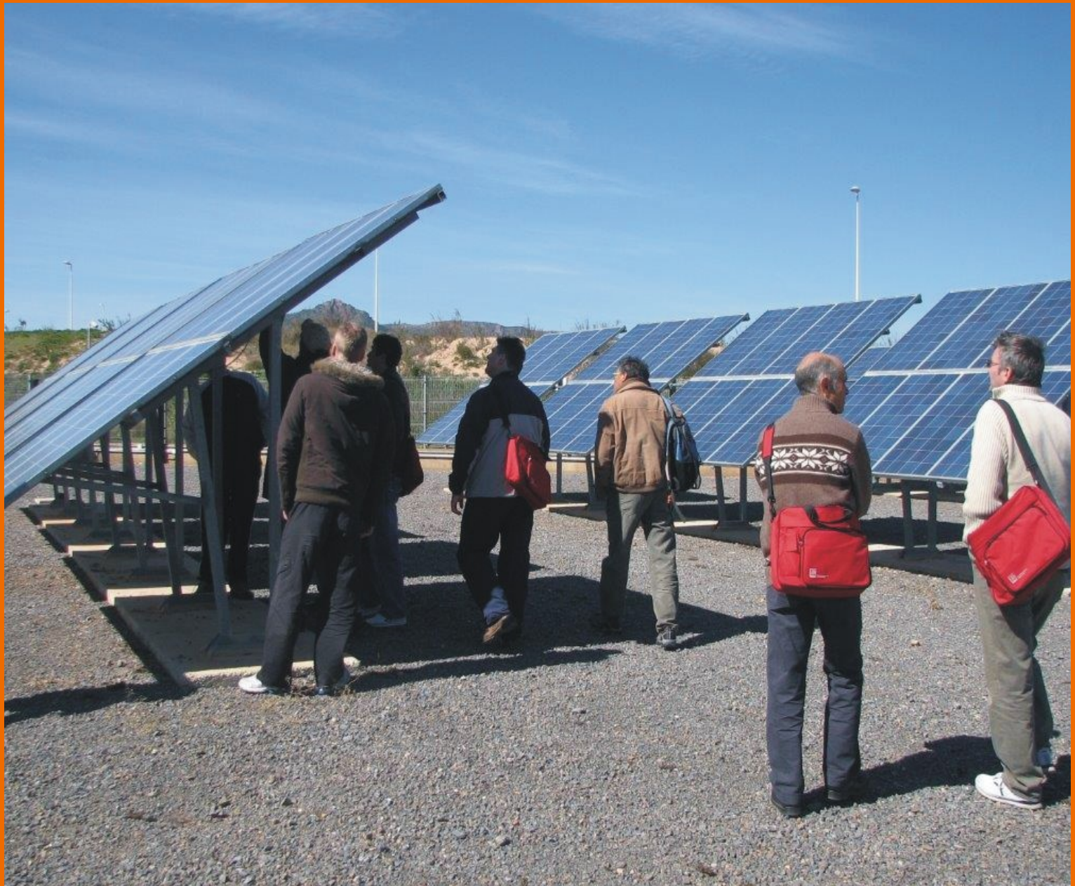
Imatge: Curs sobre energies renovables. Visita a la planta fotovoltaica del CEACV
