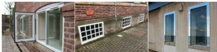
Figura 22: Ventana resistente a las inundaciones. Abatible (Mengineering)
