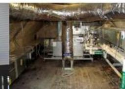
Figura 60: Reubicación de instalación en espacio bajo cubierta (FEMA)
