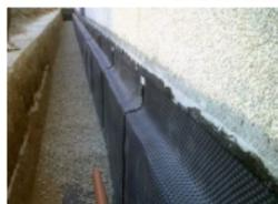
Figura 31: Sistema de drenaje de muro (ferreteriicornellana.com)
