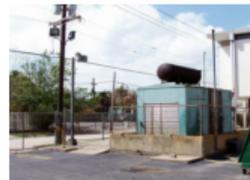
Figura 49: Barrera exterior protegiendo generador eléctrico (FEMA)
