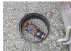
Figura 64: Válvula antirretorno (Aquobex)
