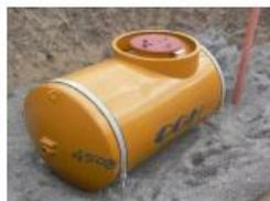
Figura 52: Tanque sobre suelo anclado con correas (cghnordic)
